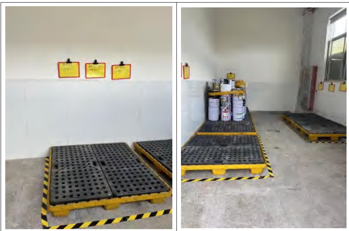
危废仓库内部
