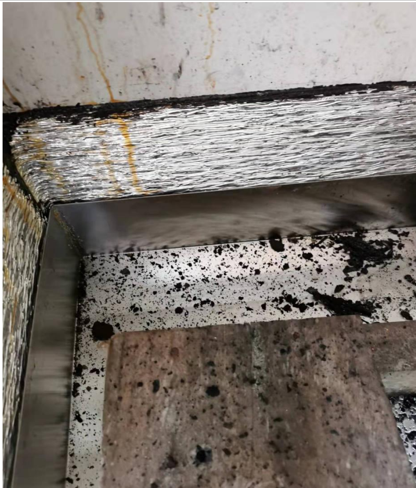
危废堆地面防腐防渗还采用不锈钢盘，上面放托盘
